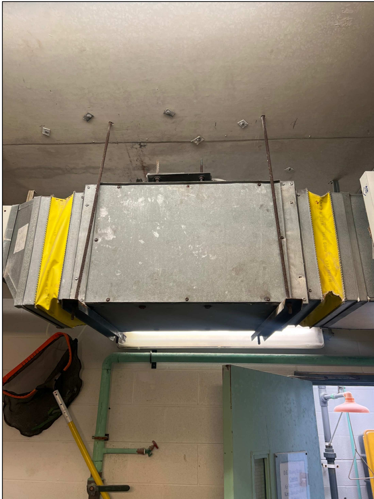
5 FIRST FLOOR SITE PHOTOS M7 SCALE: N.T.S.
