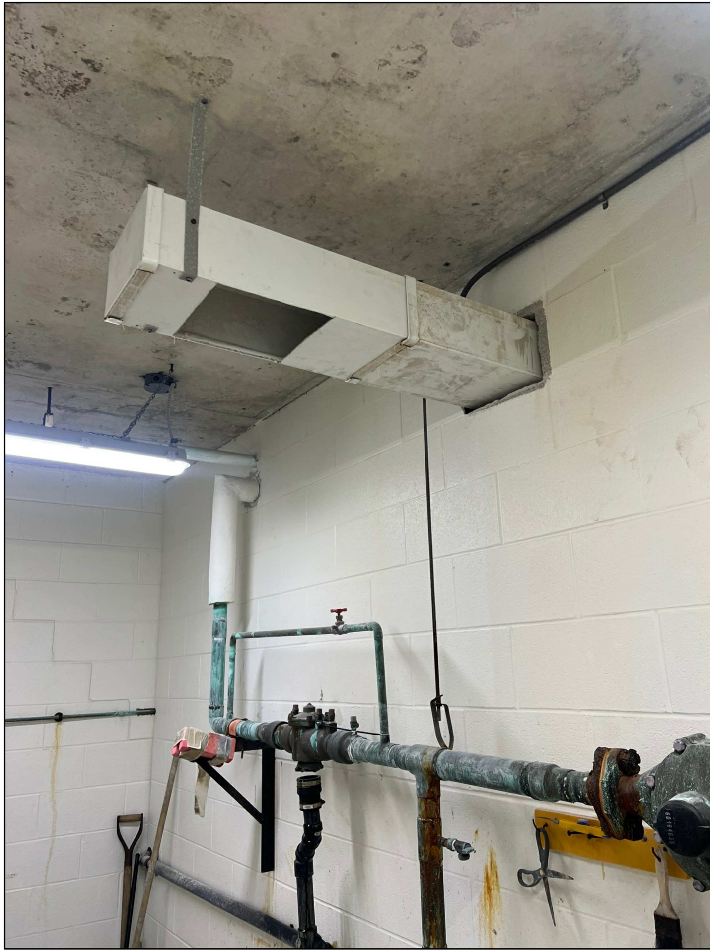
1 FIRST FLOOR SITE PHOTOS M7 SCALE: N.T.S.
