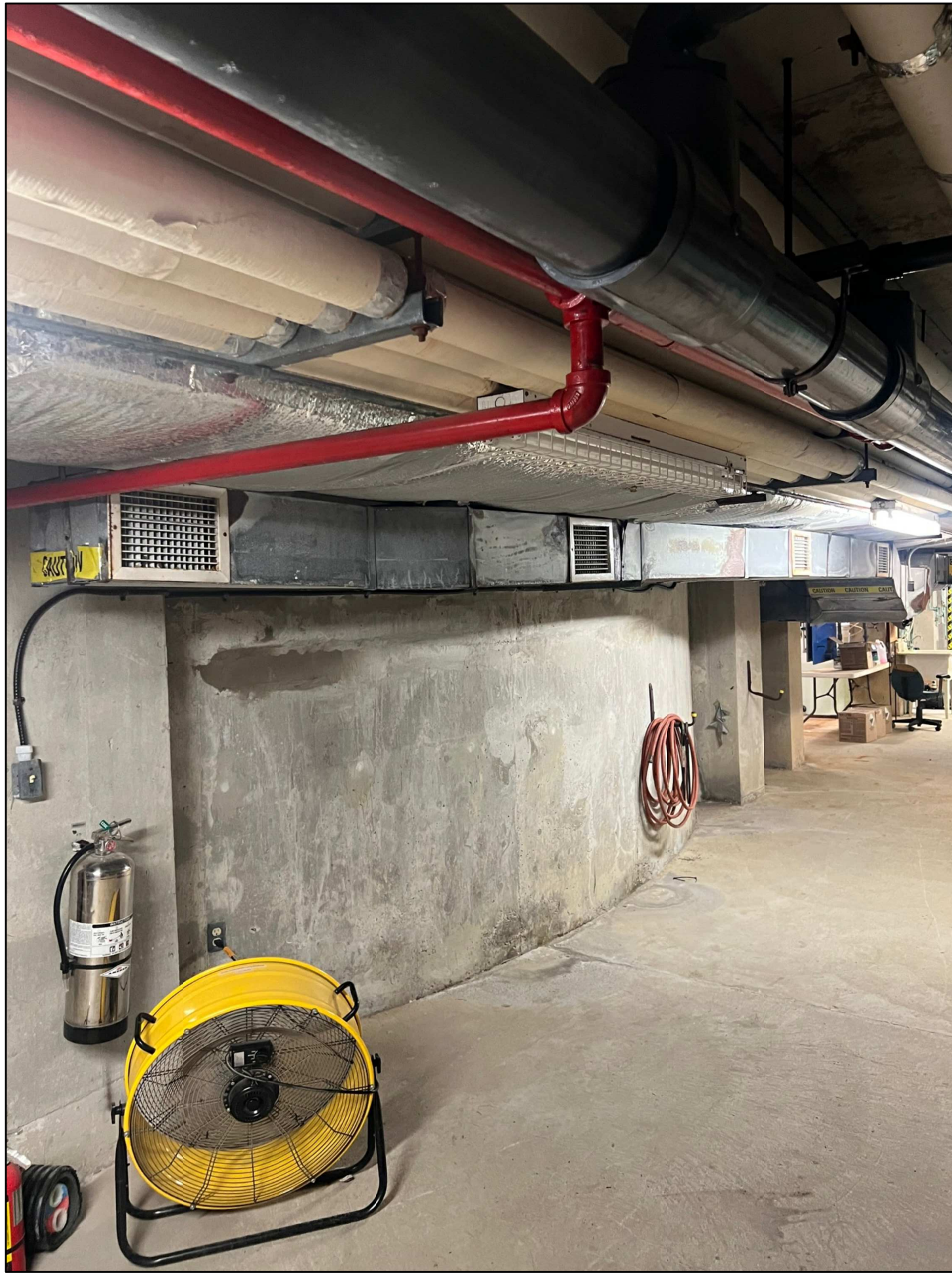
1 BASEMENT POOL TUNNEL SITE PHOTOS M8 SCALE: N.T.S.
