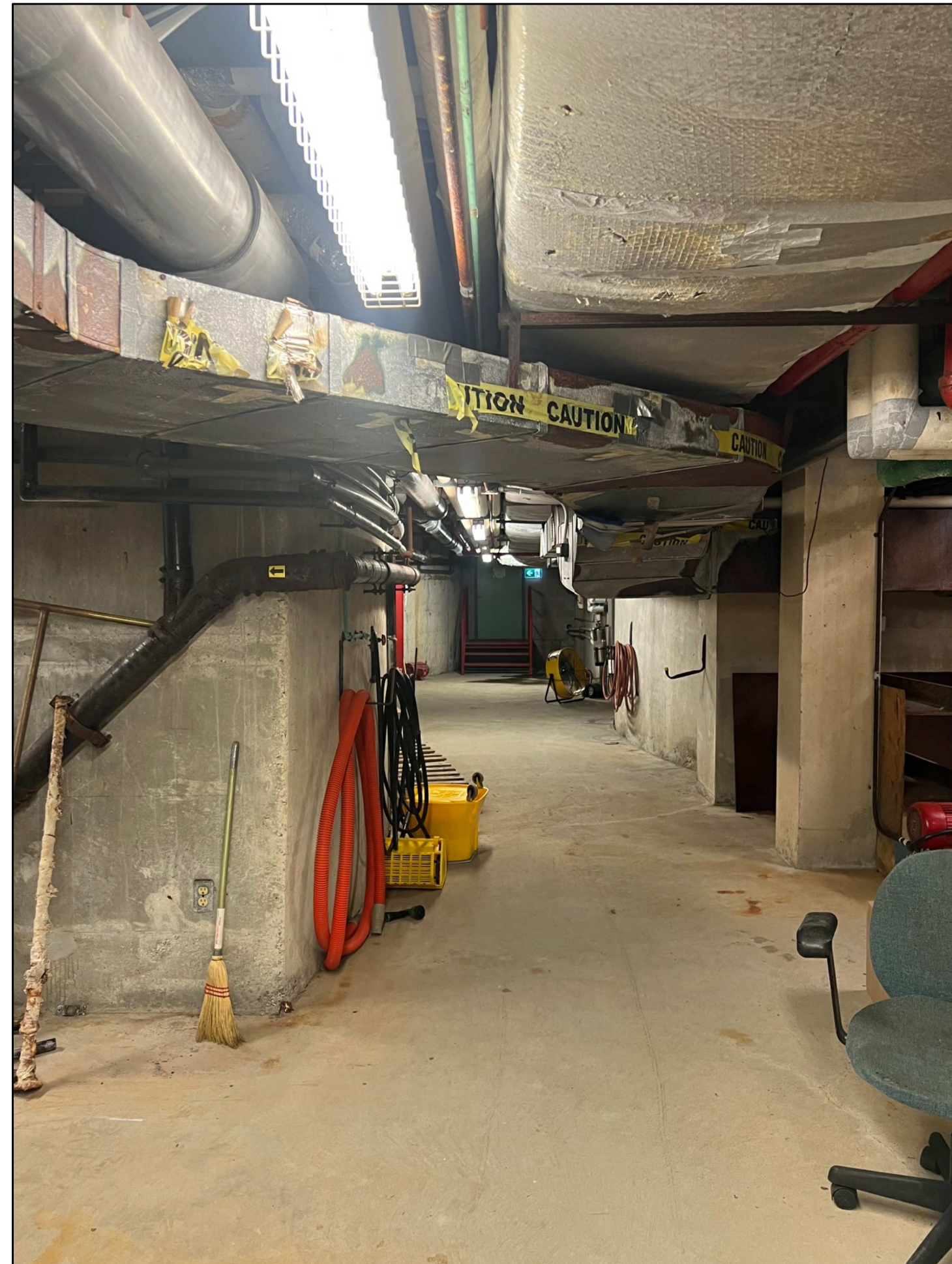
6 BASEMENT POOL TUNNEL SITE PHOTOS M8 SCALE: N.T.S.
