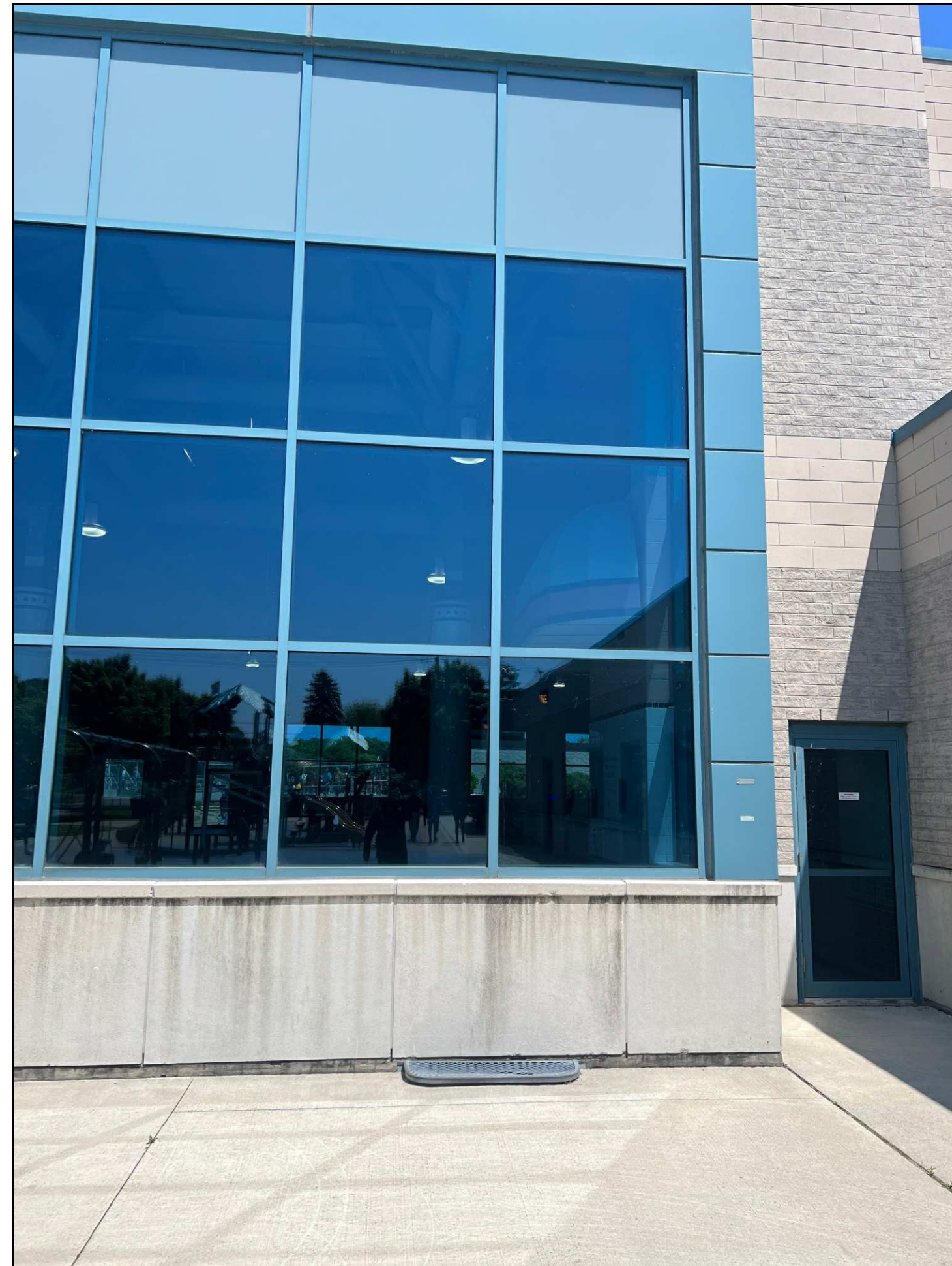
6 EXTERIOR SITE PHOTOS M7 SCALE: N.T.S.
