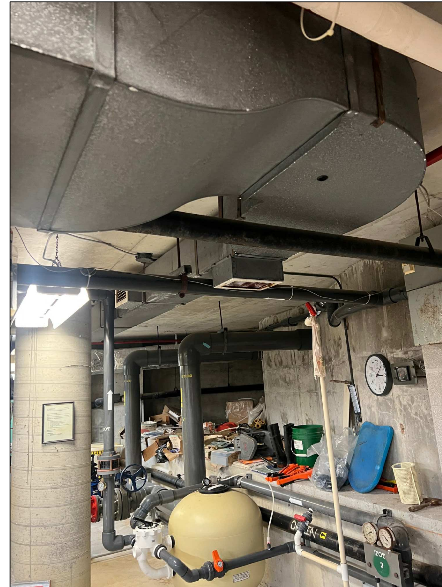
8 BASEMENT POOL TUNNEL SITE PHOTOS M8 SCALE: N.T.S.
