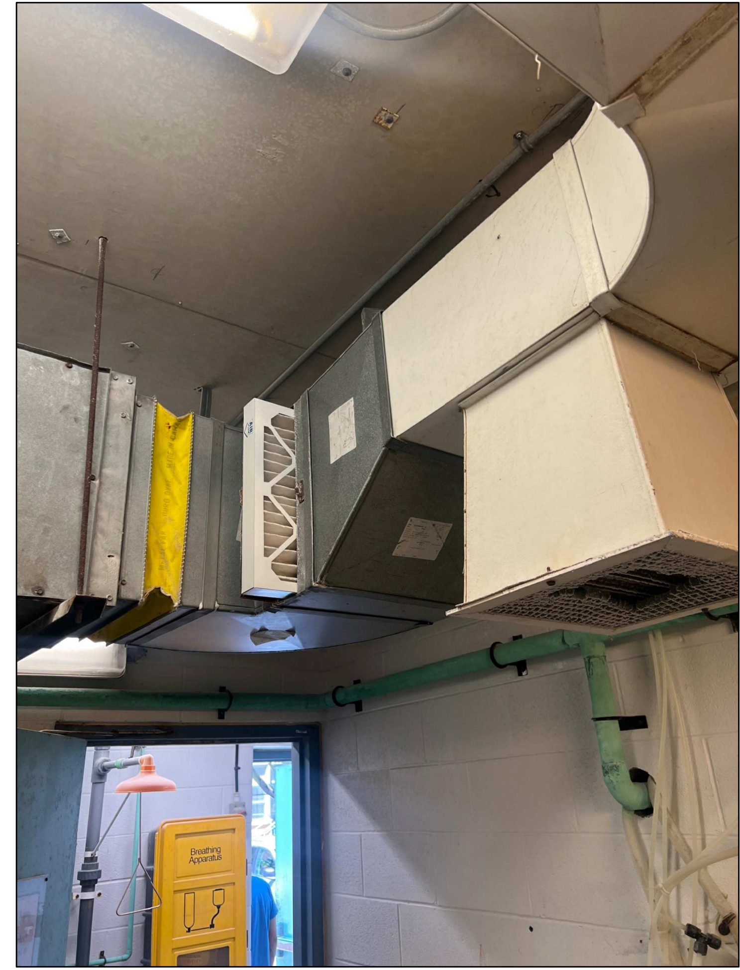
4 FIRST FLOOR SITE PHOTOS M7 SCALE: N.T.S.
