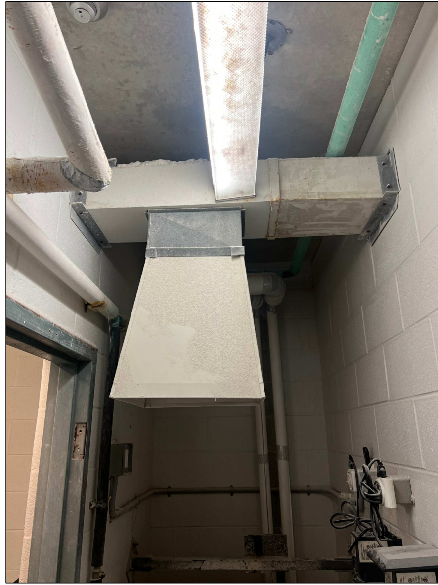
2 FIRST FLOOR SITE PHOTOS M7 SCALE: N.T.S.
