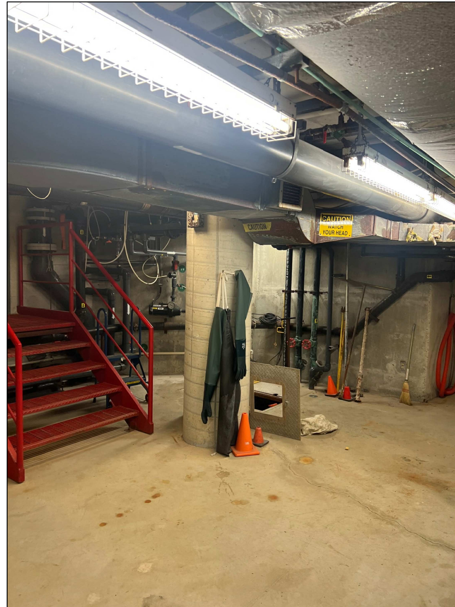
7 BASEMENT POOL TUNNEL SITE PHOTOS M8 SCALE: N.T.S.
