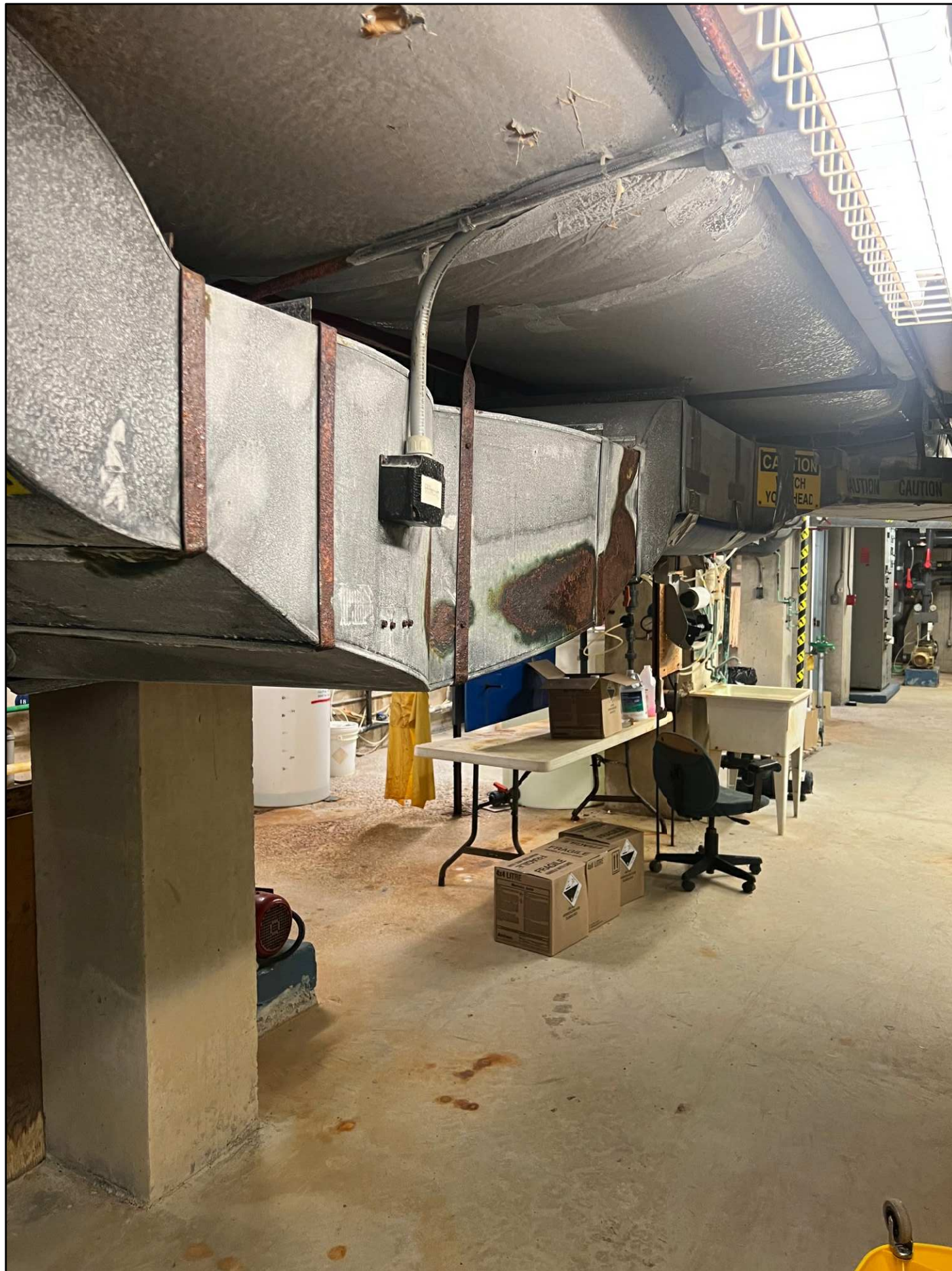
5 BASEMENT POOL TUNNEL SITE PHOTOS M8 SCALE: N.T.S.
