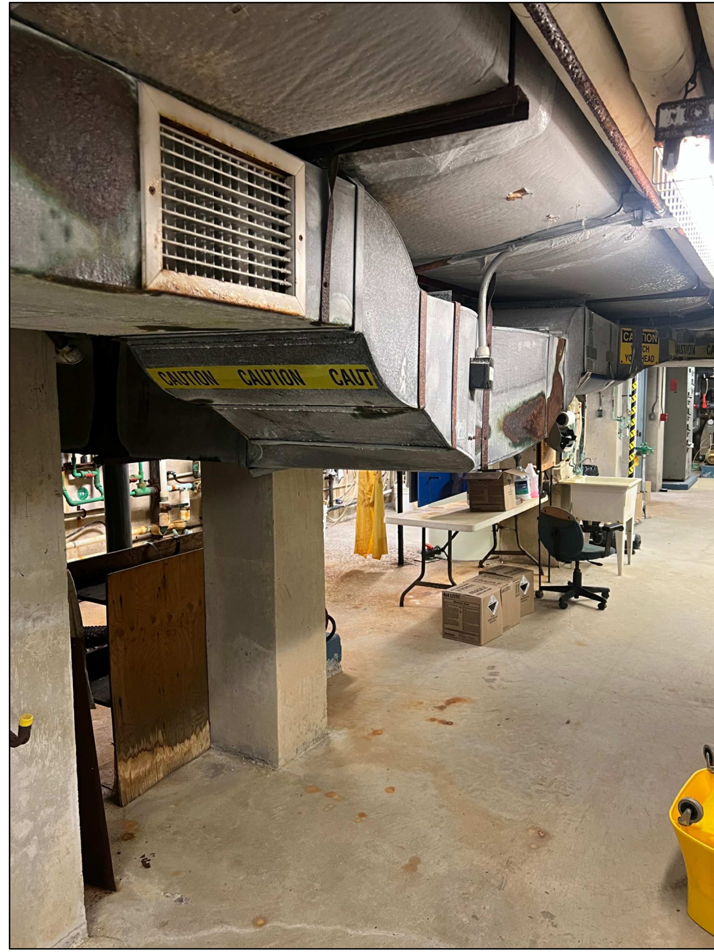
2 BASEMENT POOL TUNNEL SITE PHOTOS M8 SCALE: N.T.S.
