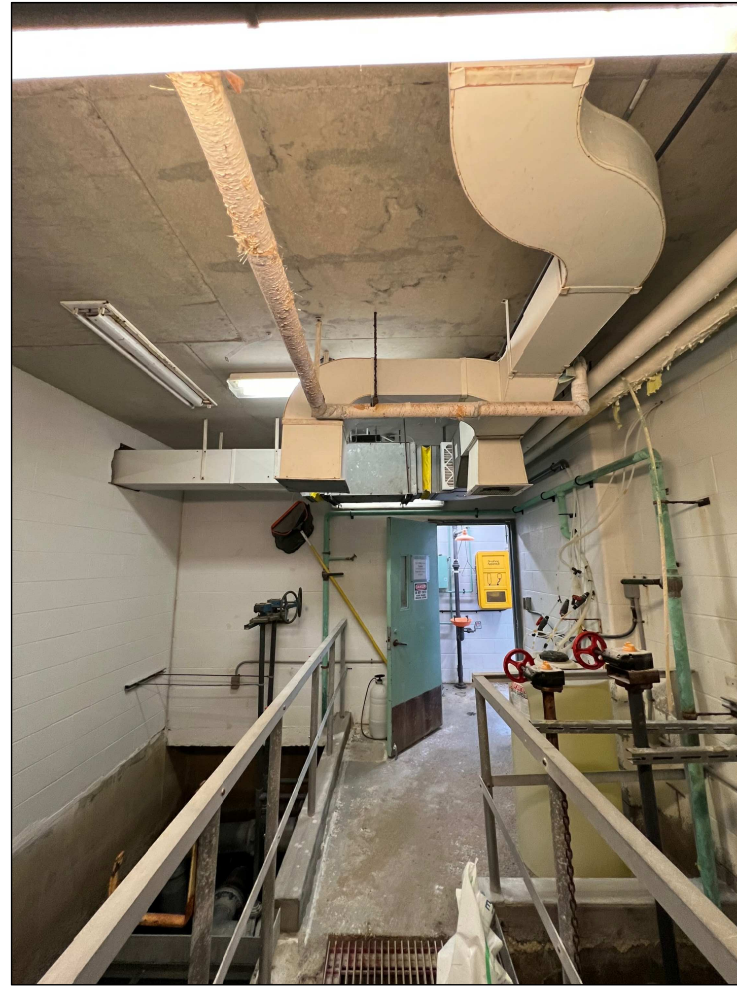
3 FIRST FLOOR SITE PHOTOS M7 SCALE: N.T.S.
