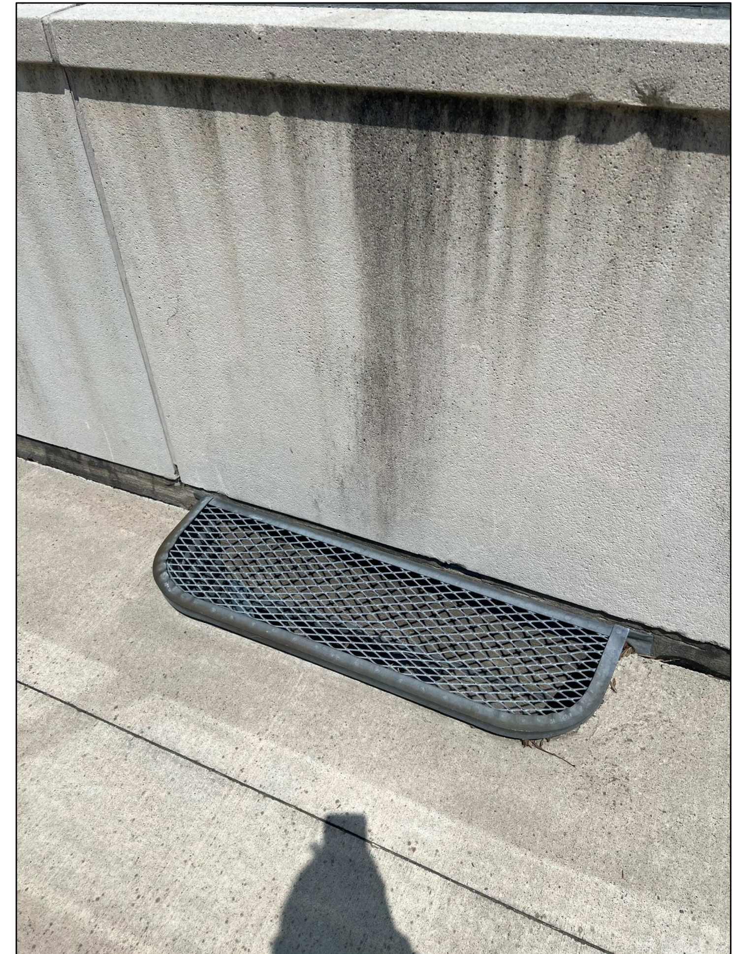
8 EXTERIOR SITE PHOTOS M7 SCALE: N.T.S.
