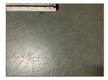
Presumed asbestos-containing vinyl floor tiles (VFT05).
