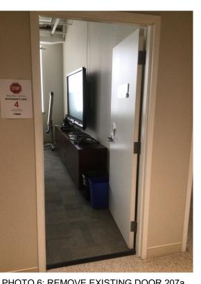
PHOTO 6: REMOVE EXISTING DOOR 207a AND WIDEN THE OPENING TO RECEIVE **NEW DOOR**
